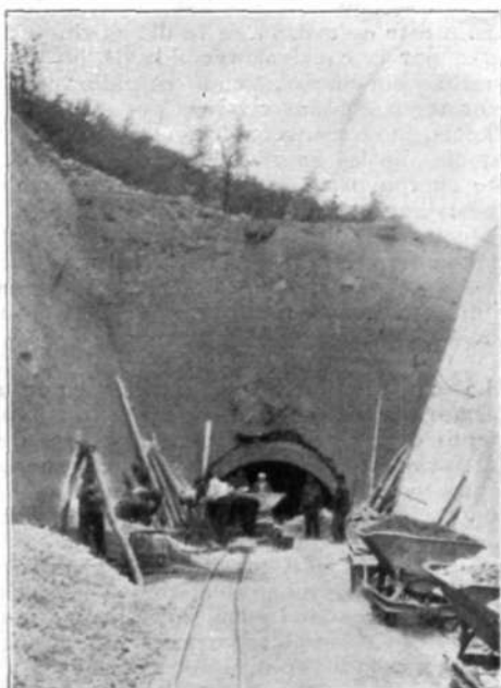
TIVENYS.—Boca de entrada del primer túnel construido por la Real Compañía de Canalización y Riegos del Ebro (1.100 metros de largo).
