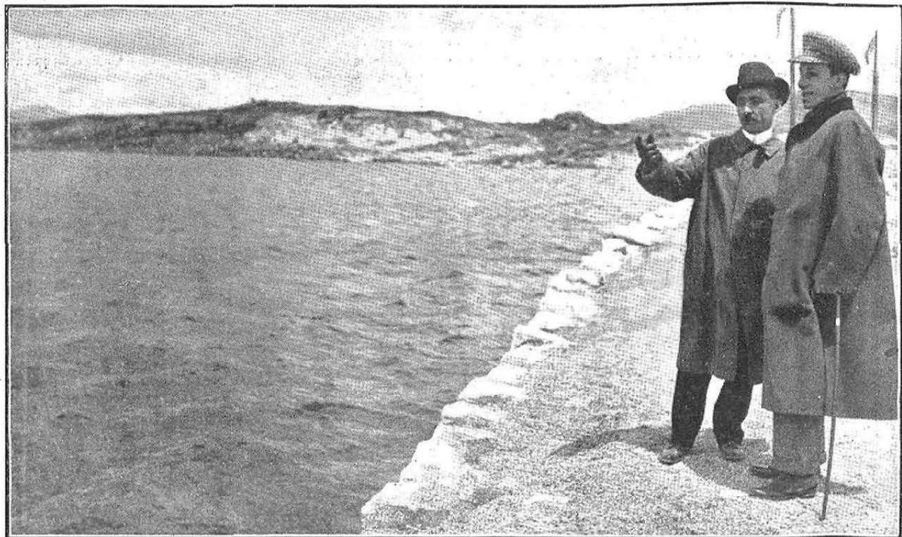
El marqués de Santillana explicando á Don Alfonso XIII, sobre el muro de contención del embalse, la importancia de las obras realizadas
