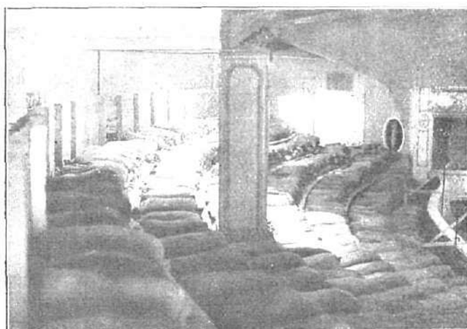
Voladizo del anfiteatro durante las pruebas de resistencia
