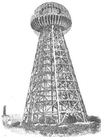
La famosa torre de energía de Shoreham, Long Island, ideada por Nikola Tesla, para transmitir caballos de fuerza a través de toda la tierra. Fue desmontada al declararse la guerra europea. Su inventor trata de construir actualmente una parecida en las cataratas del Niágara.
