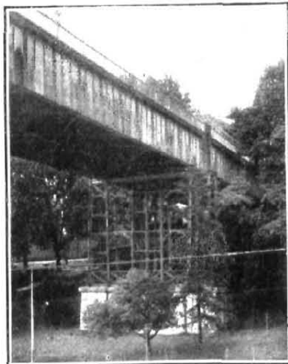
Vista del viaducto á ojo de ratón
