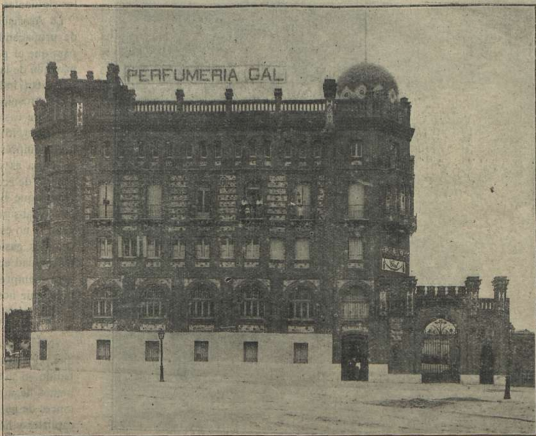
FACHADA PRINCIPAL DE LA FÁBRICA
