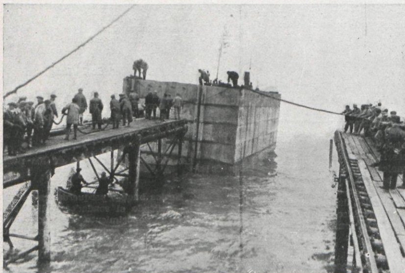
Las obras del puerto de Dunkerque.
