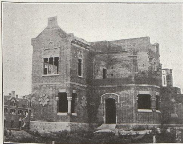
Casa de operaciones
