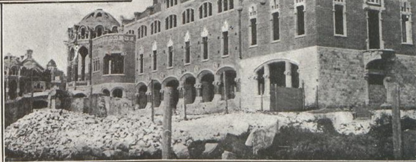
Pabellón de cirugía, parte de aislamiento
