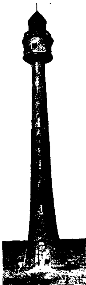
Faro de hormigón armado.
