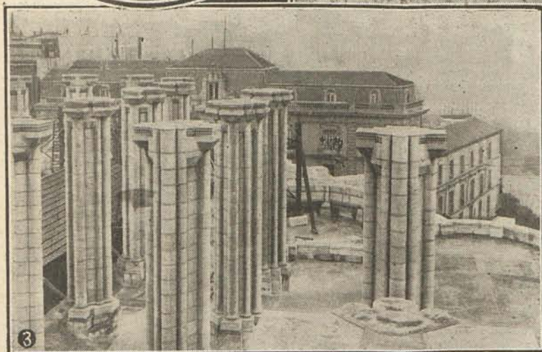
Estado actual de las obras.
