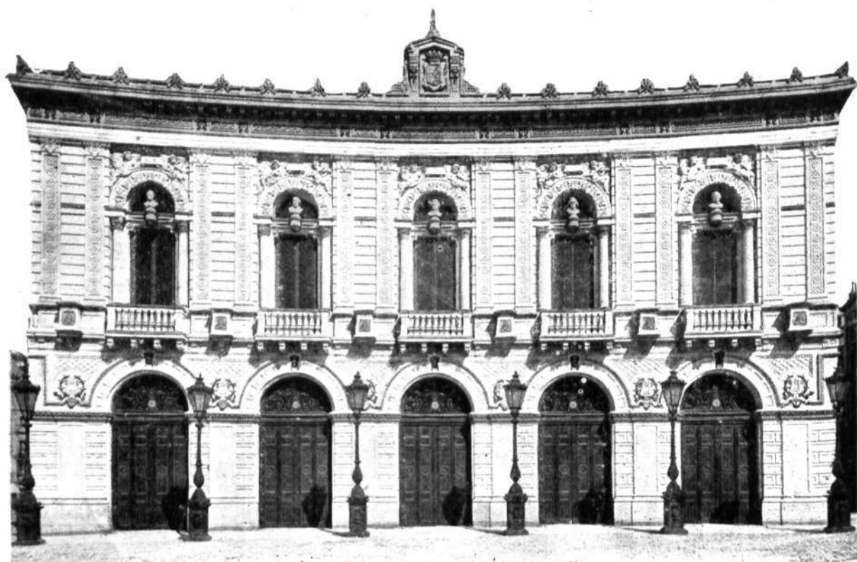
TEATRO REAL.—Fachada de la Plaza de Oriente
