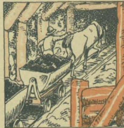
Se empleó entonces en una mina de Killingworth. Ya se usaban las vagonetas en las minas, pero eran tiradas por caballos y rodaban sobre rieles de madera. Stephenson, que conocía a fondo el mecanismo de las máquinas de vapor, construyó una capaz de arrastrar las vagonetas. Esta máquina, que requería rieles de hierro y no de madera, redujo el número de caballos que hasta entonces había necesidad de emplear en las minas.
