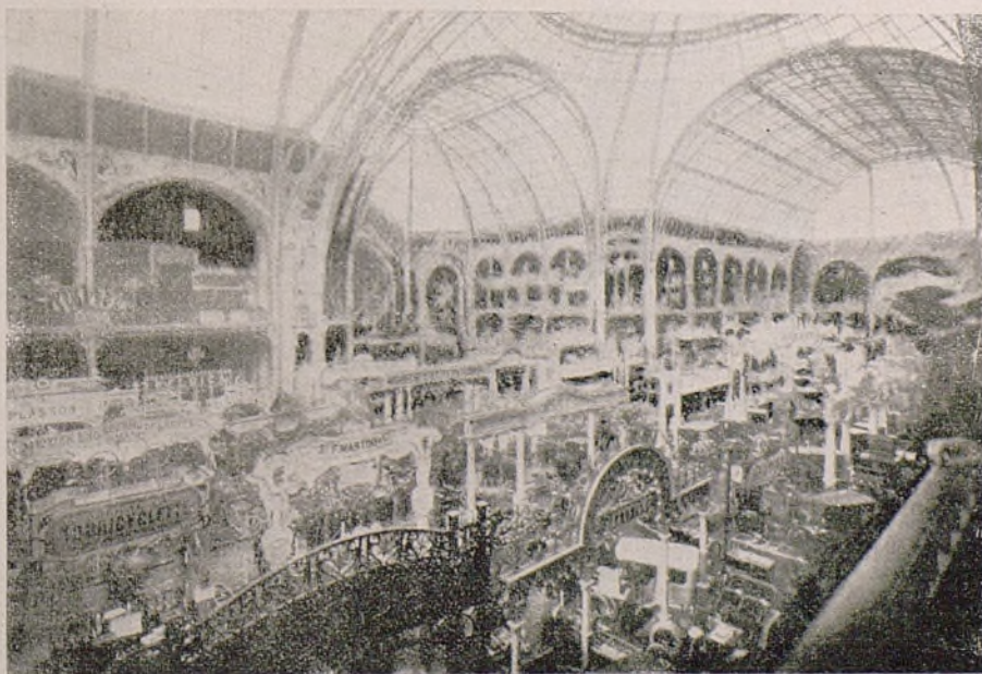
Aspecto del interior del salón.
