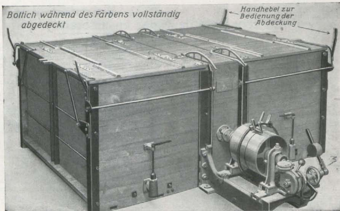
Cuba con tapadera, posición cerrada — Modelo de la casa Eduard Esser Co. G. m. b. H., de Görlitz
