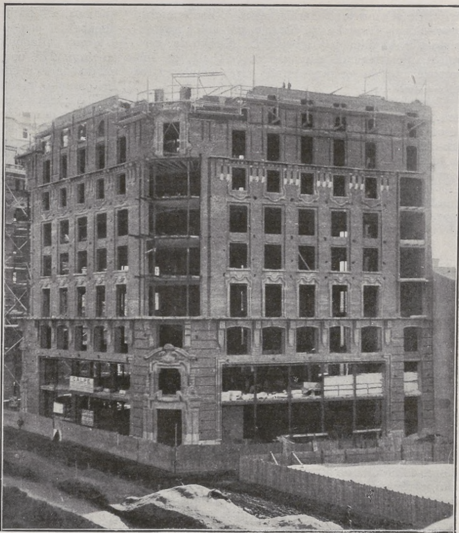
ESTADO ACTUAL DE LA OBRA
