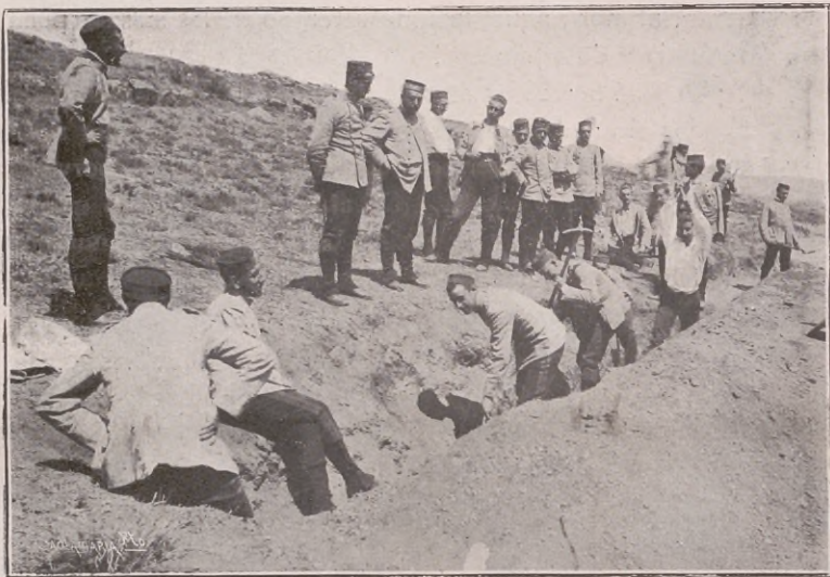
Construyendo una trinchera.
