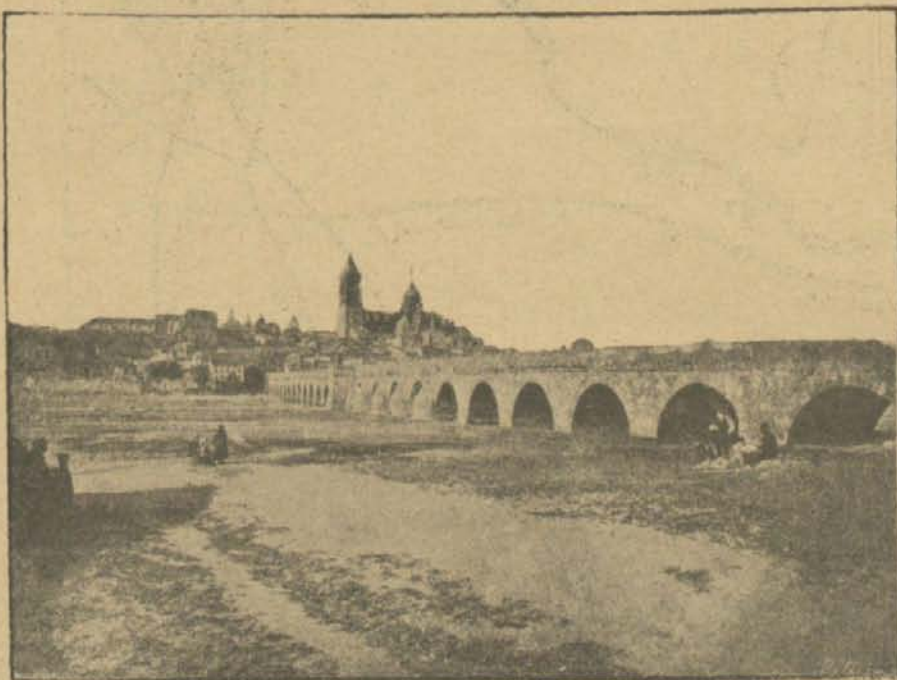
Puente sobre el Tormes (Salamanca), DONDE EMPEZARÁ LA CARRERA DE 12 DE MAYO
