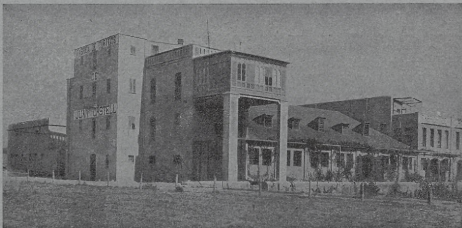
Vista exterior de la fábrica.
