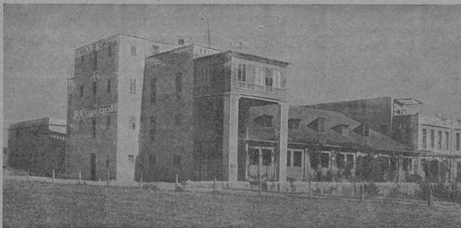
Vista exterior de la fábrica.
