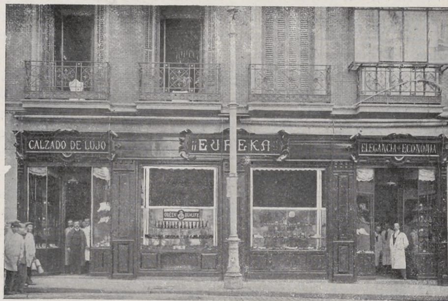
Exterior del importante establecimiento de calzado «EUREKA».
