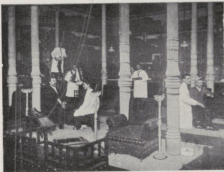
Visita parcial del interior.
