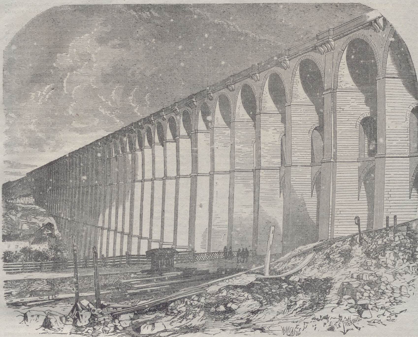
PUENTE-VIADUCTO DE CHAUMONT.
