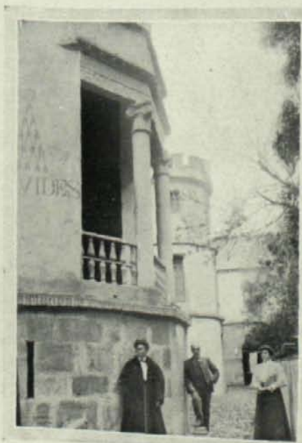
Aspecto exterior del Palacio de Santa María de Huerta
