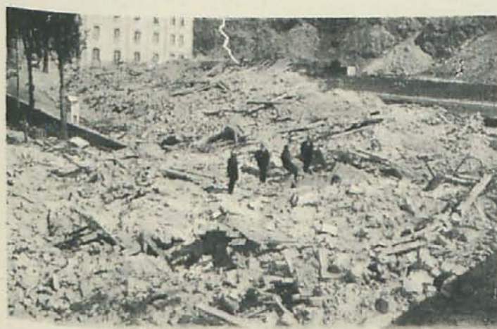
HOTEL DE LA PRADERA REDUCIDO A ESCOMBROS POR EL ALUD
