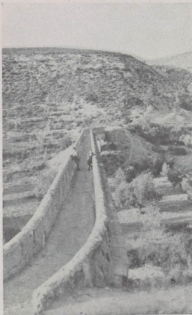
Cajero del acueducto sobre el río Blanco. Al fondo, boca de túnel de 2.100 metros.
