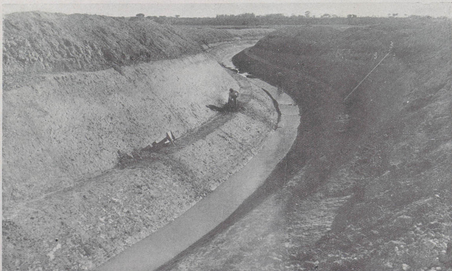
Pantano del Guadalcaacín. Trozo séptimo (en construcción).
