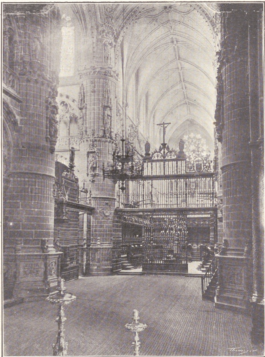
Vista de la nave central desde el Altar mayor
