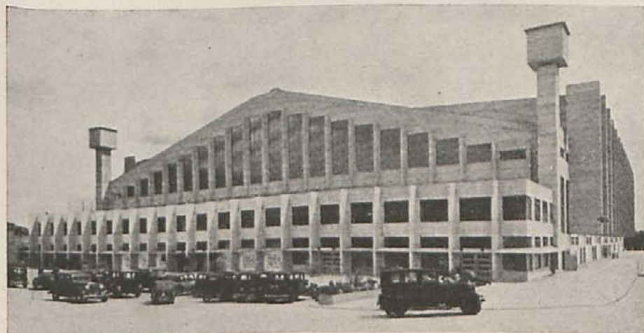
Aspecto del interior hacia el Oeste.
