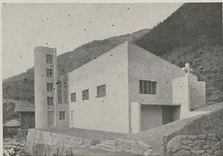
Arq. Alberto Sartoris.—Iglesia católica de Lourdes (Valais) Suiza. Tipo de edificio religioso de montaña. Vista general: fachadas Sur y Este.
