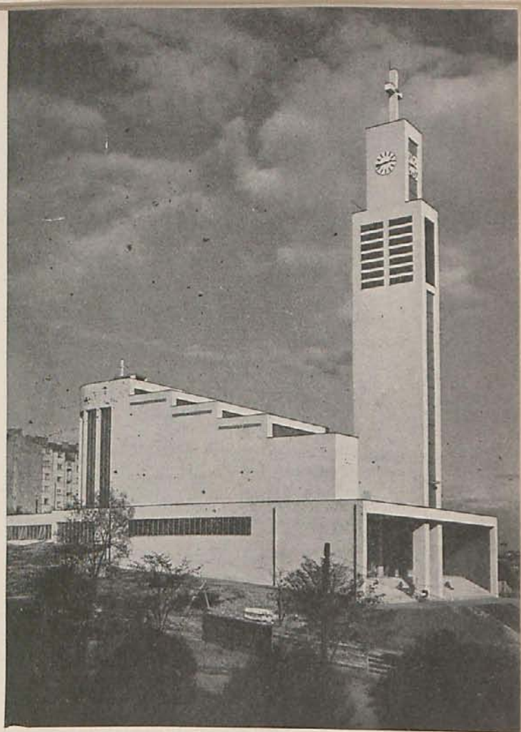
Arq. José Gocar. — Iglesia husita de S. Wenceslao, en Praga. Tipo de construcción religiosa para un barrio extremo de una gran ciudad.
