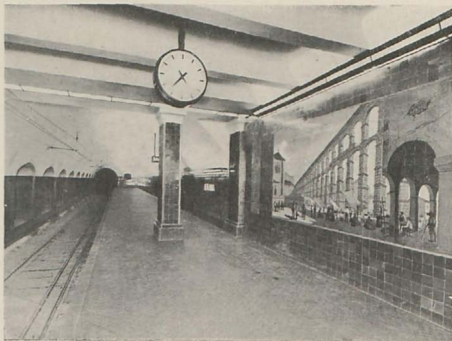
La estación Avenida de Mayo terminada. Se aprecia la artística reproducción en azulejos de acueducto de Segovia, debida a Zuloaga.
