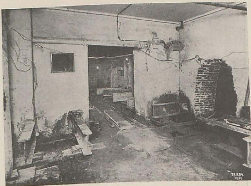
Apeo de un edificio sobre la estación Avenida de Mayo. Entrada al sótano y recalce de los muros.
