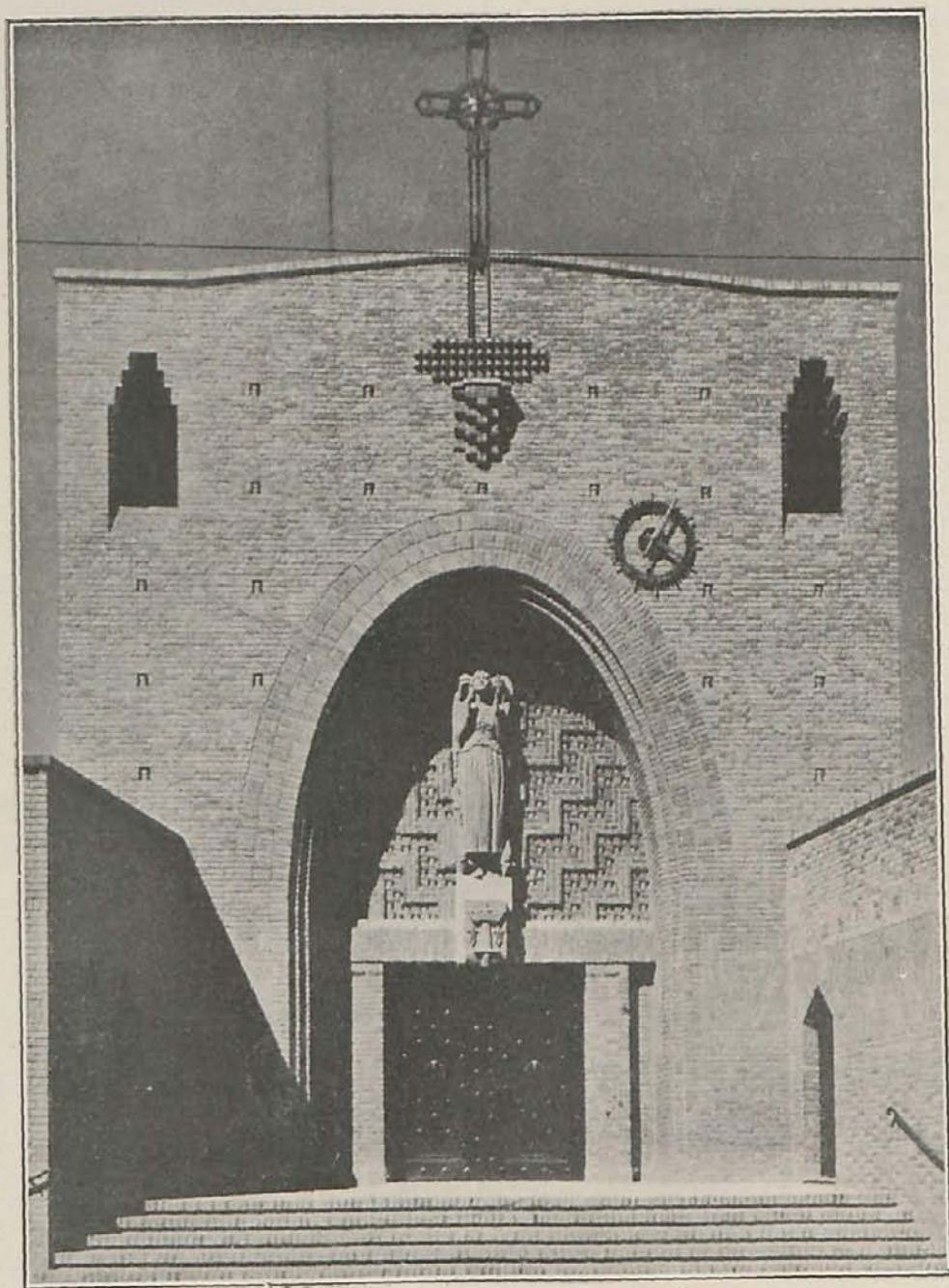
Capilla de Santa Juana de Arco, en Gennevilliers (Francia).
