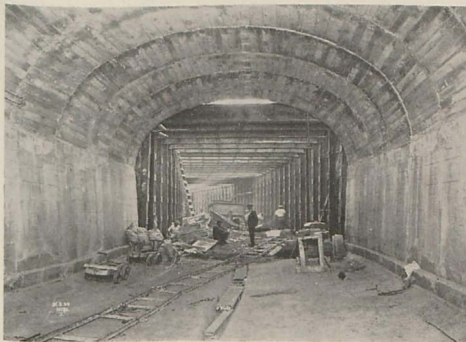
Paso de la sección en túnel a la de zanja, abierta en Plaza Constitución.
