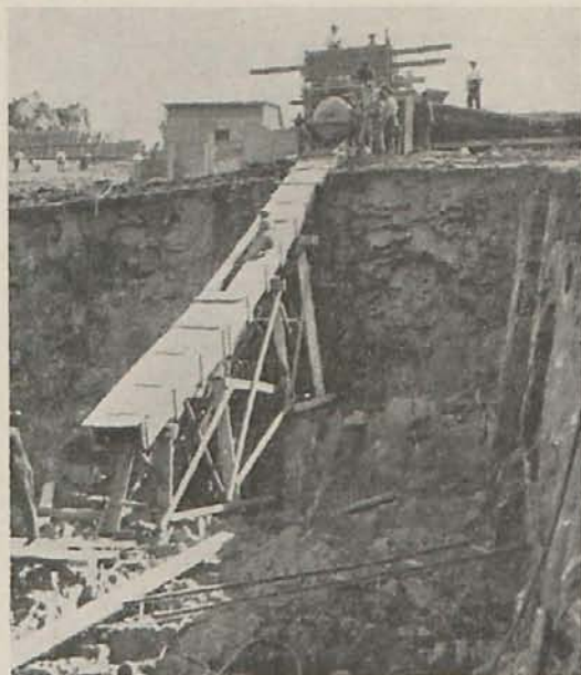
Hormigonado de la excavación para el estribo de la margen izquierda.
