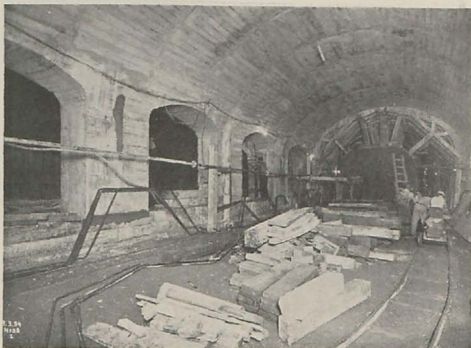
Los trabajos en la estación Avenida de Mayo en abril de 1934.
