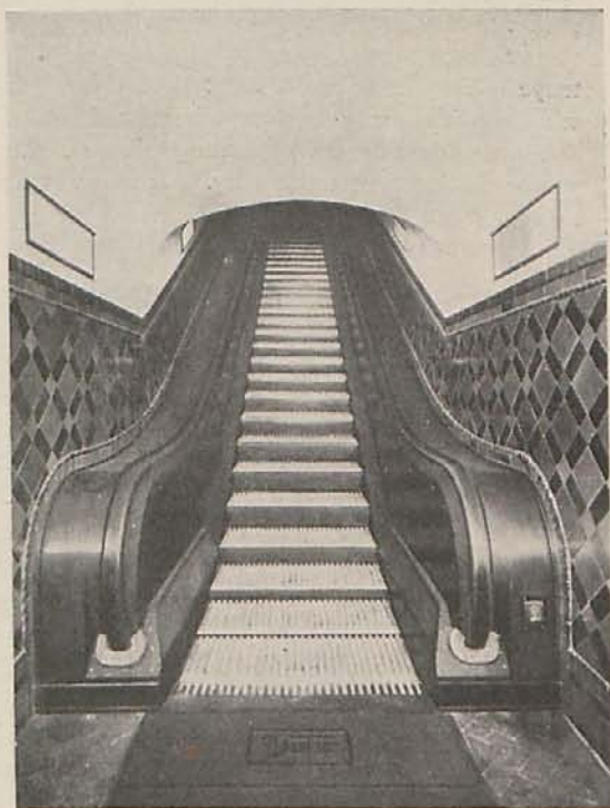
Una escalera mecánica.
