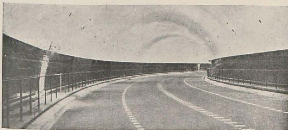
Vista interior del túnel con las cuatro vías de circulación de vehículos.
