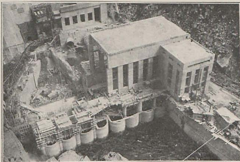
CENTRAL Y CASA DE VALVULAS. —El tubo 4 aparece a la izquierda de la casa de válvulas cerrado por una brida ciega, y el 3, cerrado dentro de la casa de válvulas, continúa fuera de ella dispuesto a recibir las virolas para su prolongación hasta la central; los tubos de los grupos 1 y 2 llegan a la central. En primer término las bocas de los tubos de aspiración cerradas por bóvedas para evitar el retroceso del agua. (Foto tomada días antes del accidente.)
