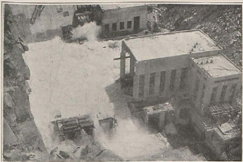
Recinto de fundación de los grupos 3 y 4 inundado por las aguas que salen de la tubería 4. Instante en que la tubería funciona a presión. Al ser mayor la velocidad el agua alcanza la casa de máquinas.
