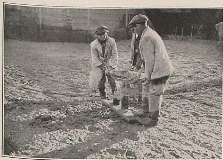
Fig. 6.<sup>a</sup>—Detalle del apisonado del hormigón.
