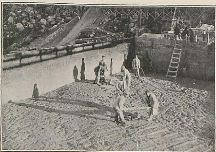
Fig. 5.—Capa de hormigón recién vibrado.
