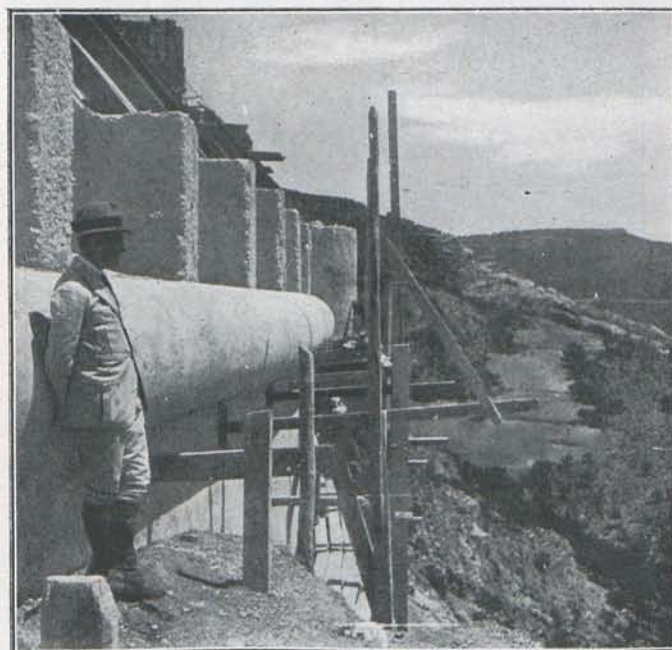
Figura 7.ª Aliviadero del depósito de carga.
