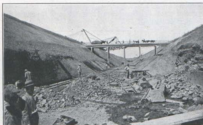
Figura 15.ª Paso superior y canal, en construcción.
