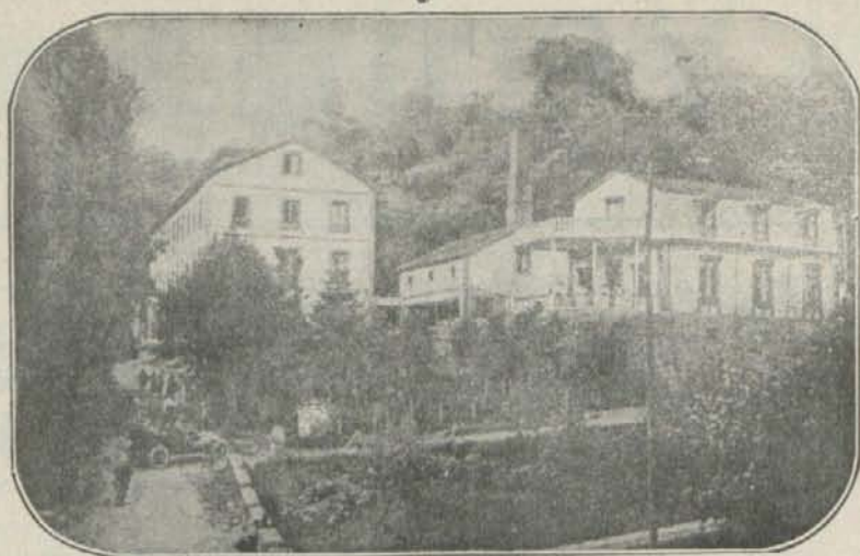
VISTA DEL BALNEARIO
