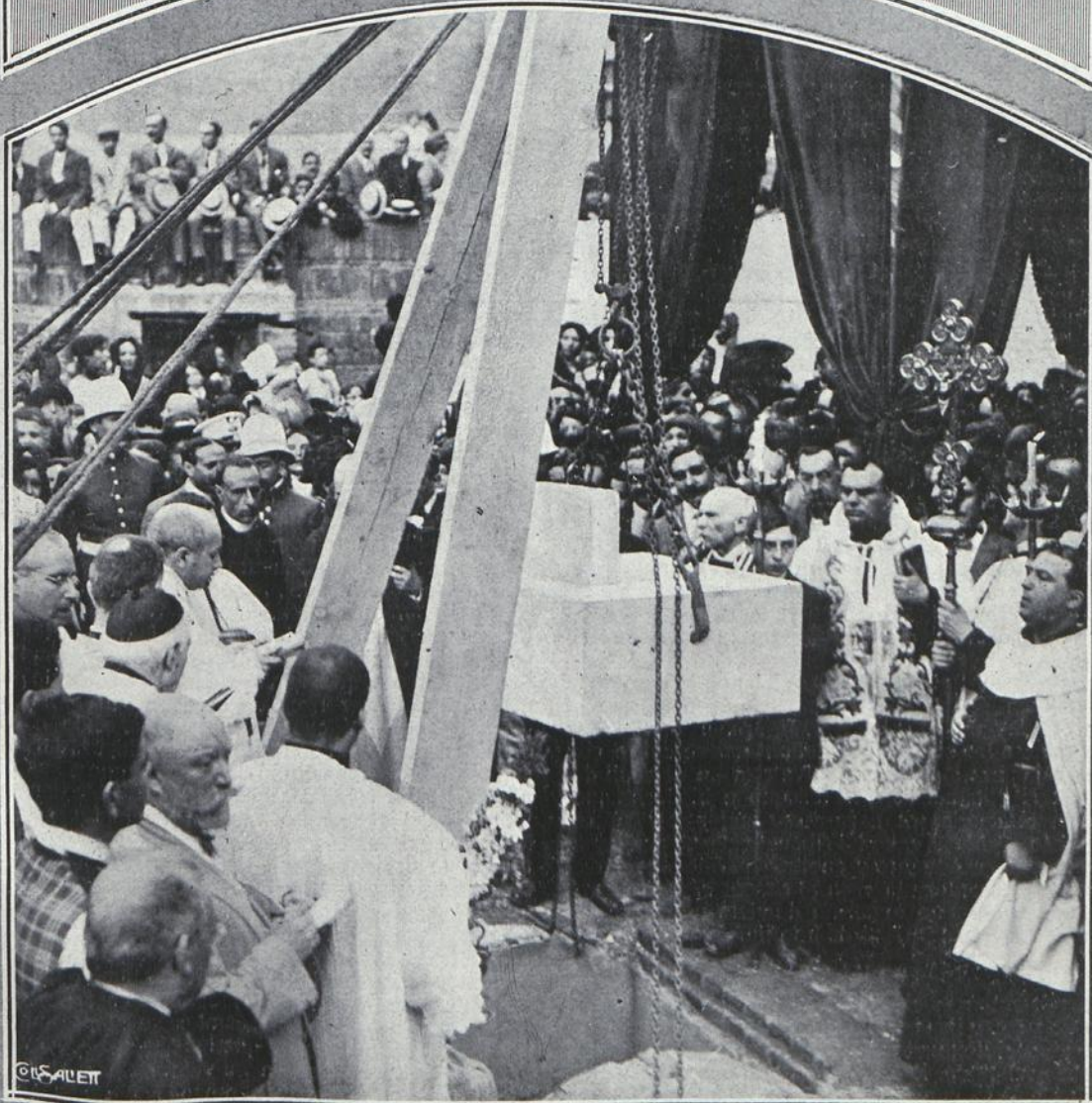
BARCELONA.—Bendición y colocación de la primera piedra del nuevo templo que se ha de construir en la residencia de los PP. Carmelitas en la Gran Vía Diagonal.—(Fotog. Baguñá y Cornet)
