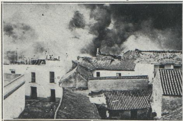
SEVILLA.—Incendio de una fábrica de corcho (Fotog. Olmedo)
