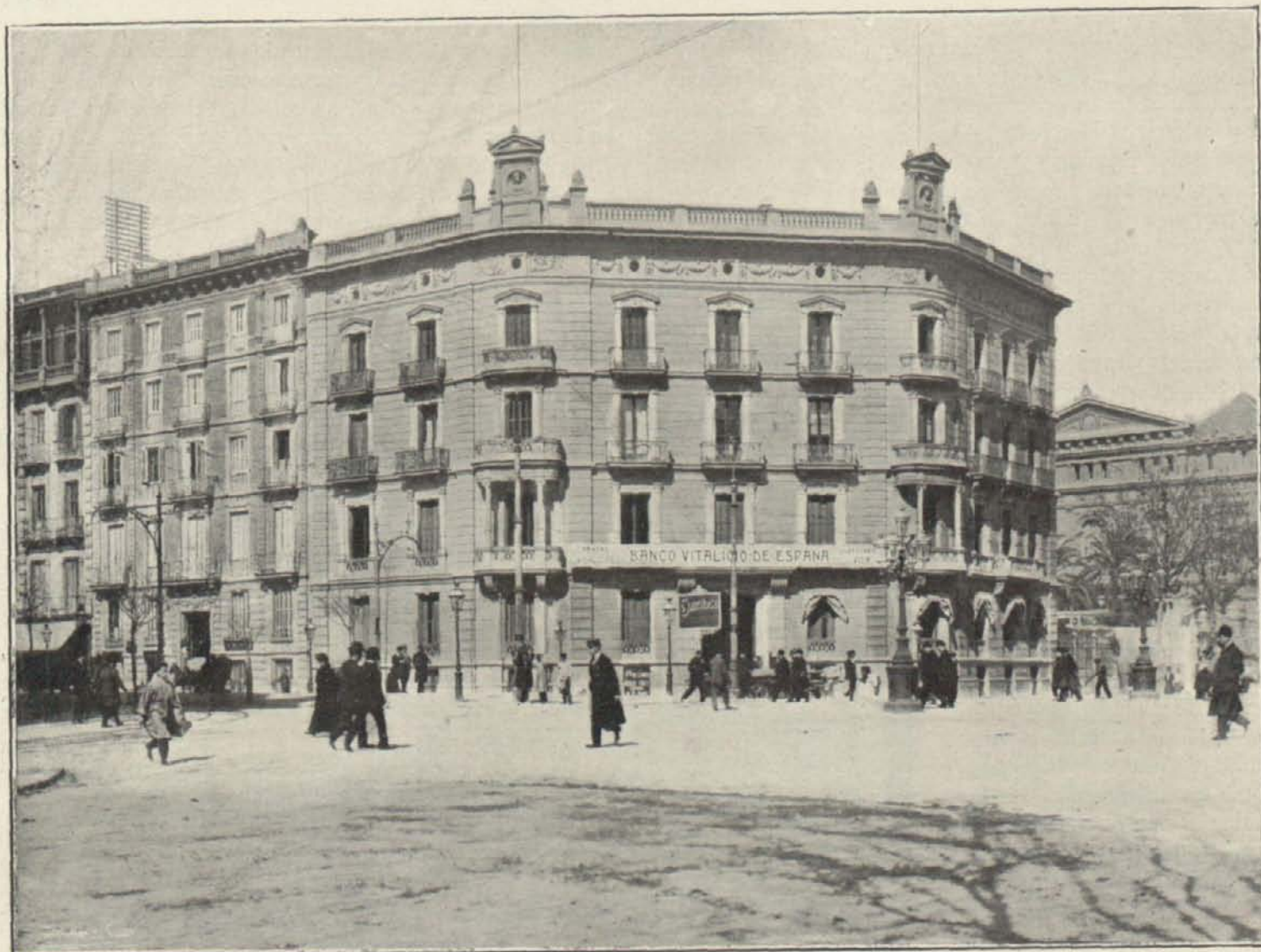
EDIFICIO EN DONDE ESTÁN INSTALADAS LAS OFICINAS CENTRALES DEL «BANCO VITALICIO DE ESPAÑA».—(Barcelona).
