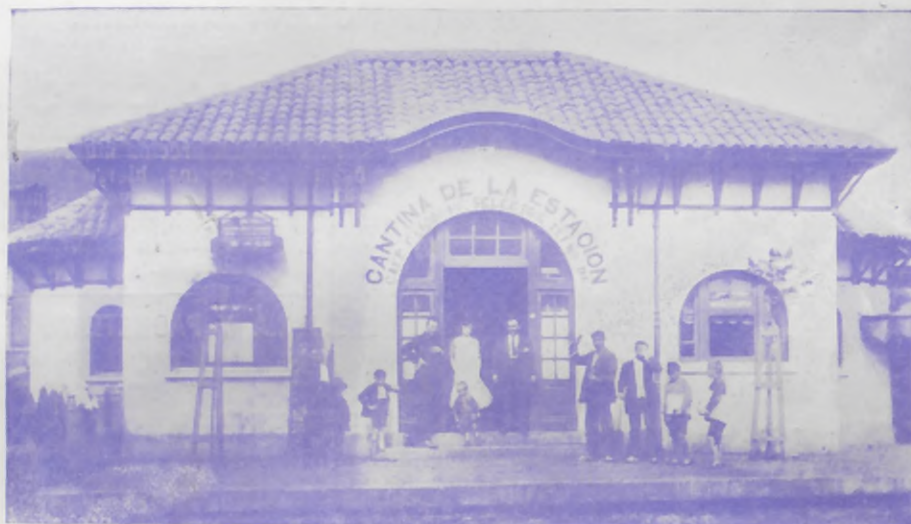
Cantina de la estación de Mieres, de la que es propietario D. Vicente Fernández González, jefe de la estación del ferrocarril Vasco.
