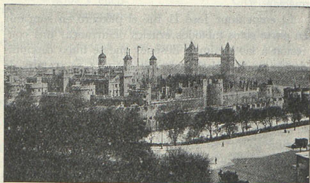
LONDRES.—La Torre y la Torre del Puente.
