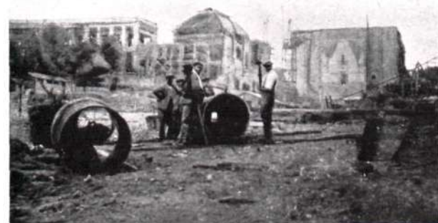
El Trocadero en demolición.
