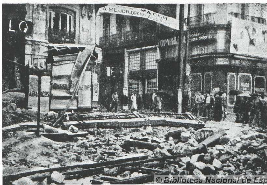
Aspecto de la Puerta del Sol bajo la acción destructora.
