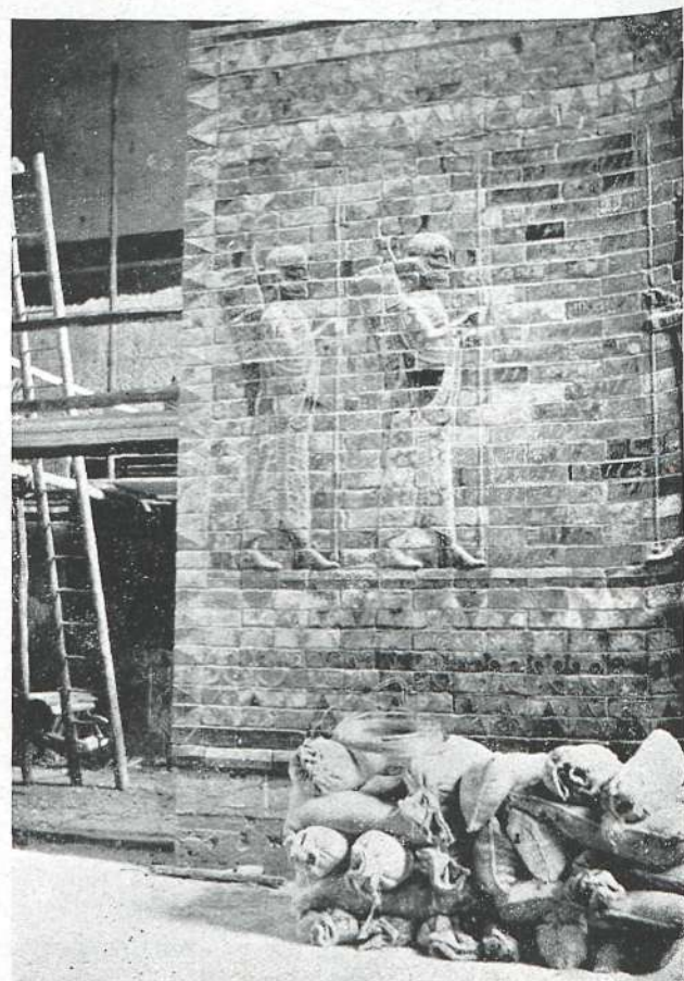
Colocación de la famosa "frise des Archers" (ladrillos), del Palacio de Susa (Persia), viejos de 3.000 años.
