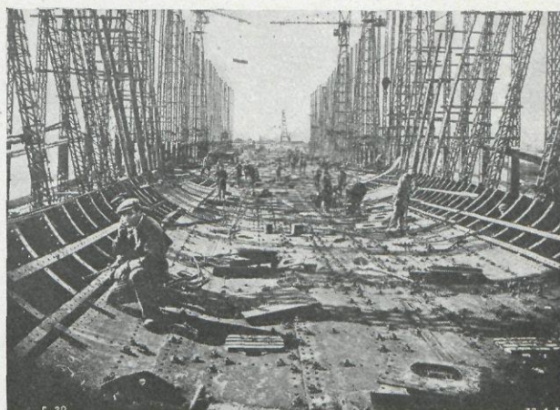
Figura 5.ª—El casco en la primera fase de su construcción (30 de abril de 1931)
