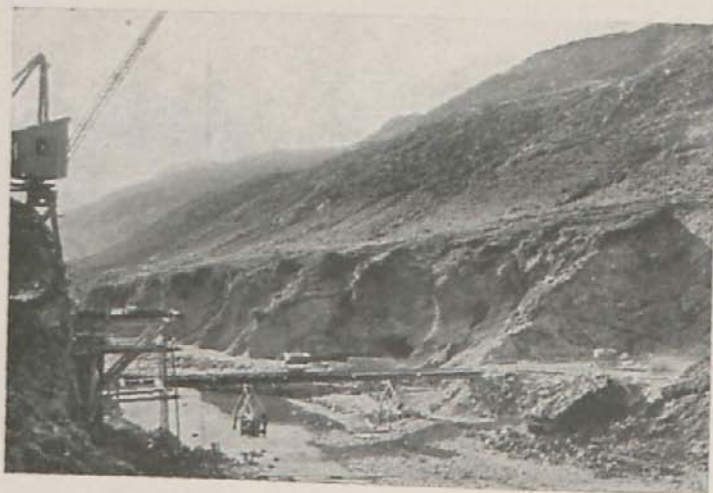
FIG. 6.* — OBRAS PARA LA CONSTRUCCIÓN DE LA CENTRAL HIDRO-ELECTRICA DE CAMPO. SE DESTACAN EN LA FOTOGRAFIA, COMO EN GRAUS, TRES FASES DE ASURCAMIENTO DEL RIO
