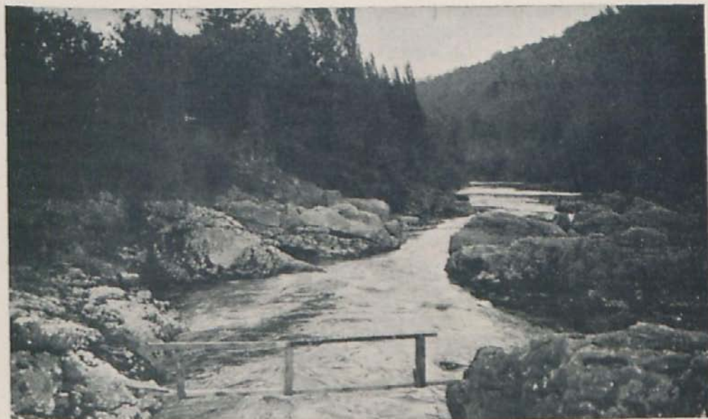
DESNIVELES Y FORMAS QUE NOS RECUERDAN LOS SALTOS Y CASCADAS DE SU JUVENTUD...
