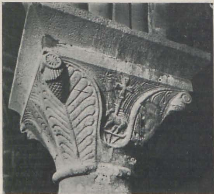
EN LA ANTIGUA SALA DE NOVICIOS, DOS DELICADÍSIMAS COLUMNAS DE ENORMES CAPITILES RECOGEN LOS NERVIOS DE LA ATREVIDA BÓVEDA.
