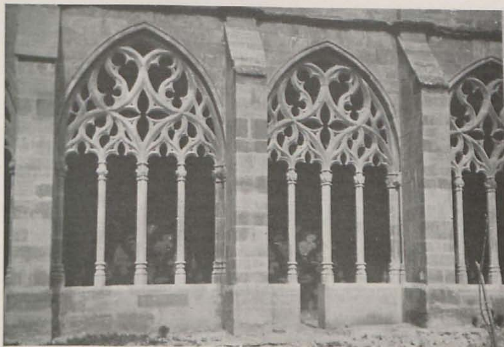
EL CLAUSTRO CONSTA DE CUATRO GALERÍAS, OSTENTANDO CADA UNA SEIS ARCADAS OJIVALES CON FINOS PARTELUCE Y VARIADÍSIMAS ROSAS POLILOBULADAS...
