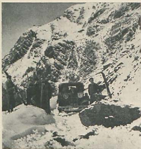
PENA CAÍDA EN LA CARRETERA, QUE IMPIDIÓ LLEGAR EN EL AUTO ORUGA HASTA EL PUEBLO DE RANSOL
