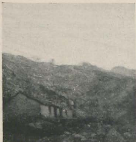
FIGURA 6.—PRIMITIVA CONSTRUCCIÓN DEL REFUGIO DE LA RENCLUSA
