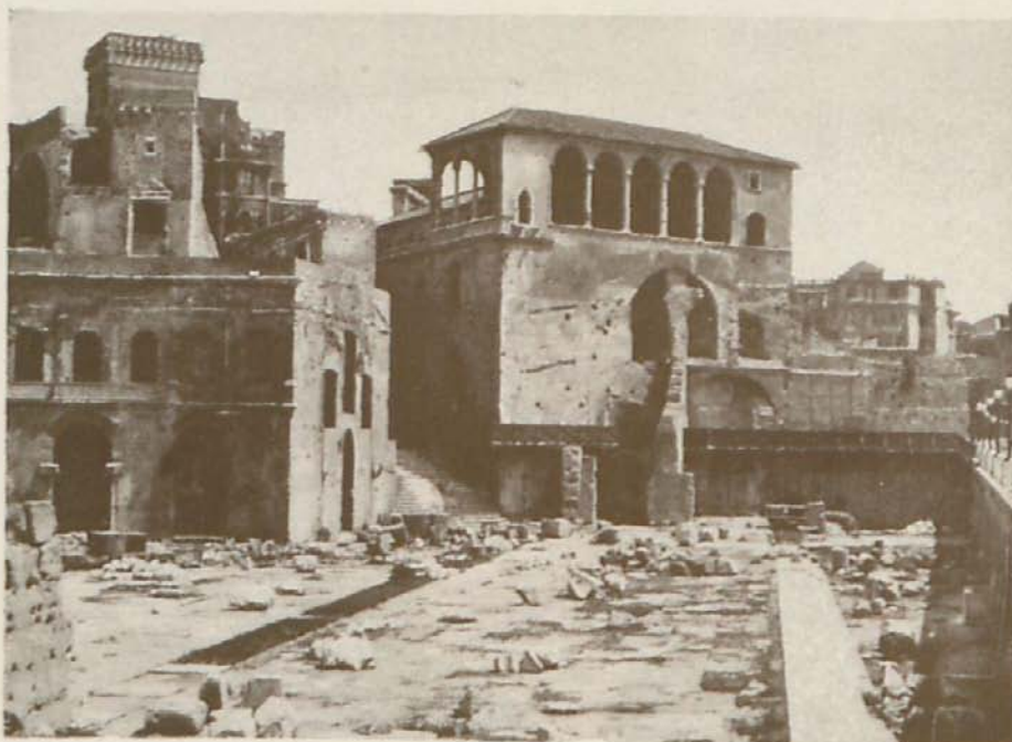
LOS MERCADOS DE TRAJANO Y LA GALERÍA DE LOS CABALLEROS DE RODI, DESPUÉS DE LA DEMOLICIÓN DE LAS CASAS QUE IMPEDIAN SU VISTA.
