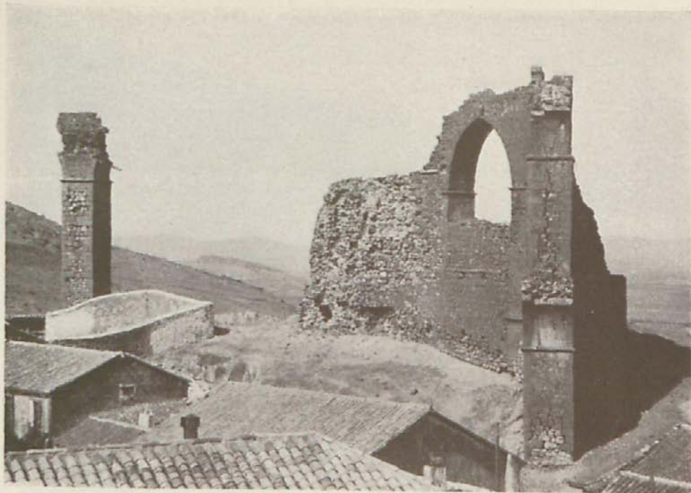
ALCARÁZ. RUINAS DEL ACUEDUCTO.
