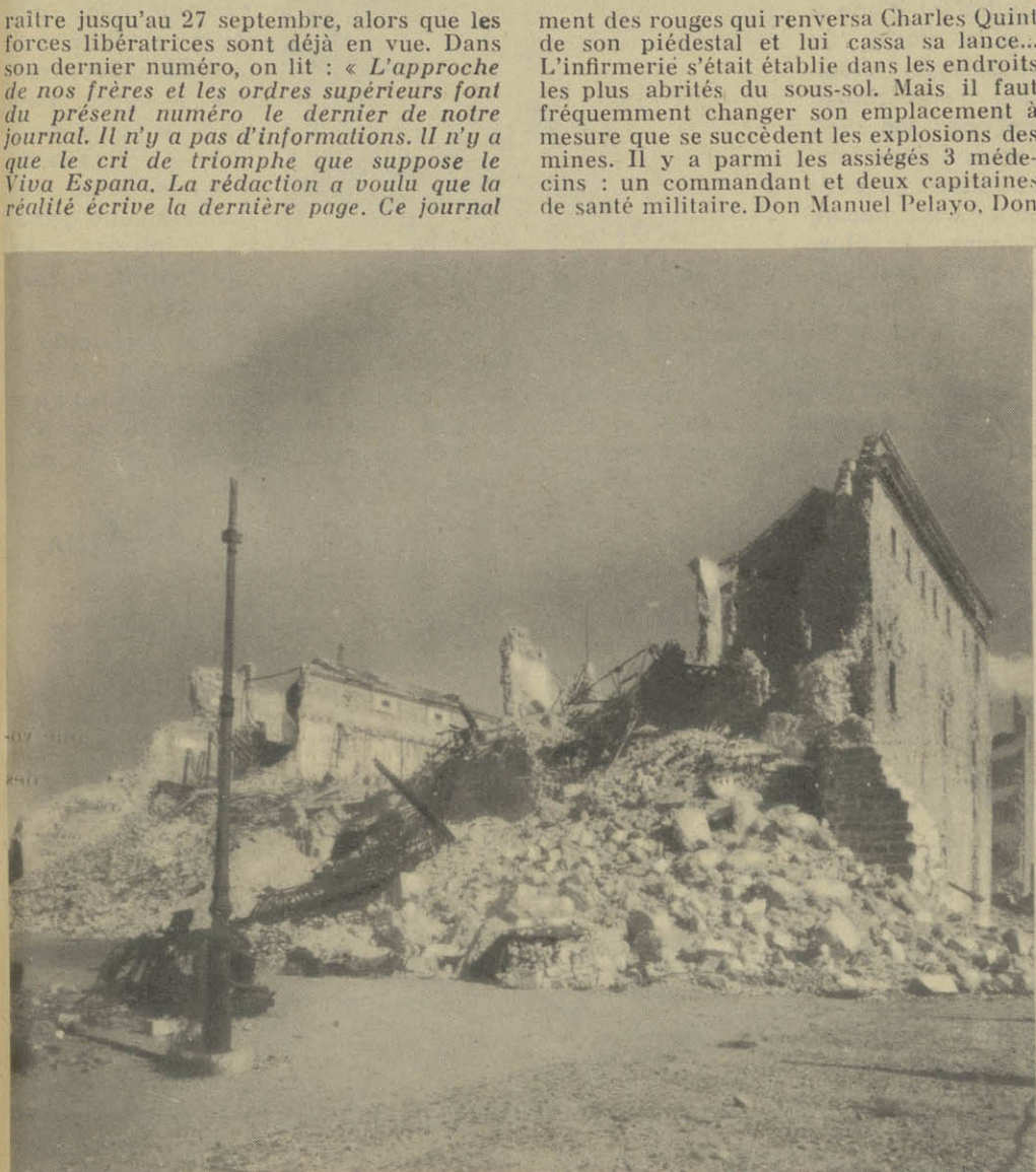
L'accès actuel à ce qui fut la terrasse de l'Alcazar aux balustrades de ciel bleu.
