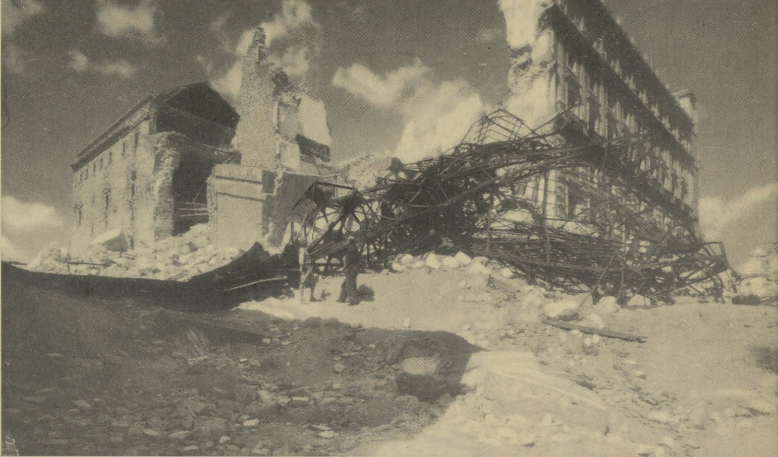
Le squelette des poutres de fer apparaissait sur la chair à nu des murs.
