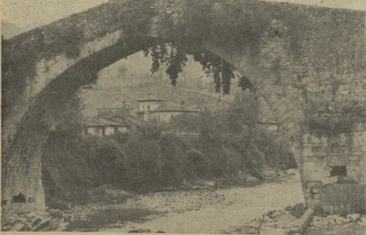
FRONT DES ASTURIÉS. — Cangas de Onís : Pont romain. On voit dans ses piles latérales, les cavités creusées par les dynamiteurs pour le faire sauter. La rapide intervention des nationaux a sauvé l'œuvre d'art.
