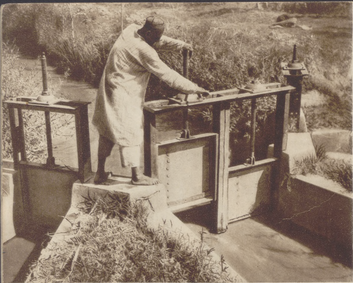
des moyens primitifs. Le nouveau système d'irrigation en Asie Centrale distribue mécaniquement l'eau dans les plantations de coton.
