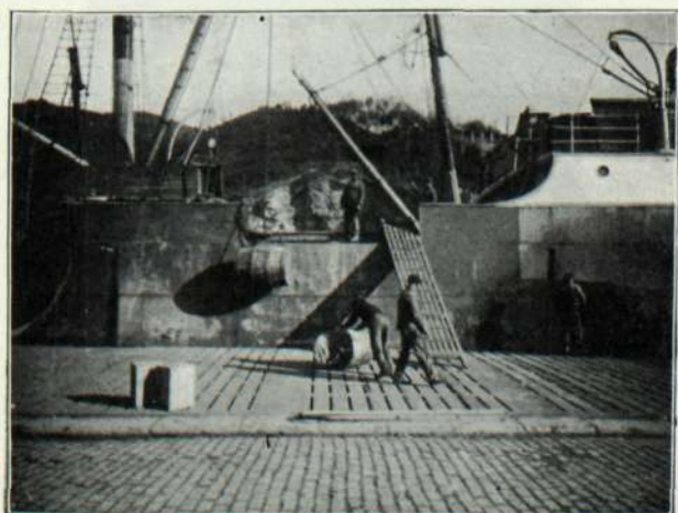
DESCARGANDO AL MUELLE
